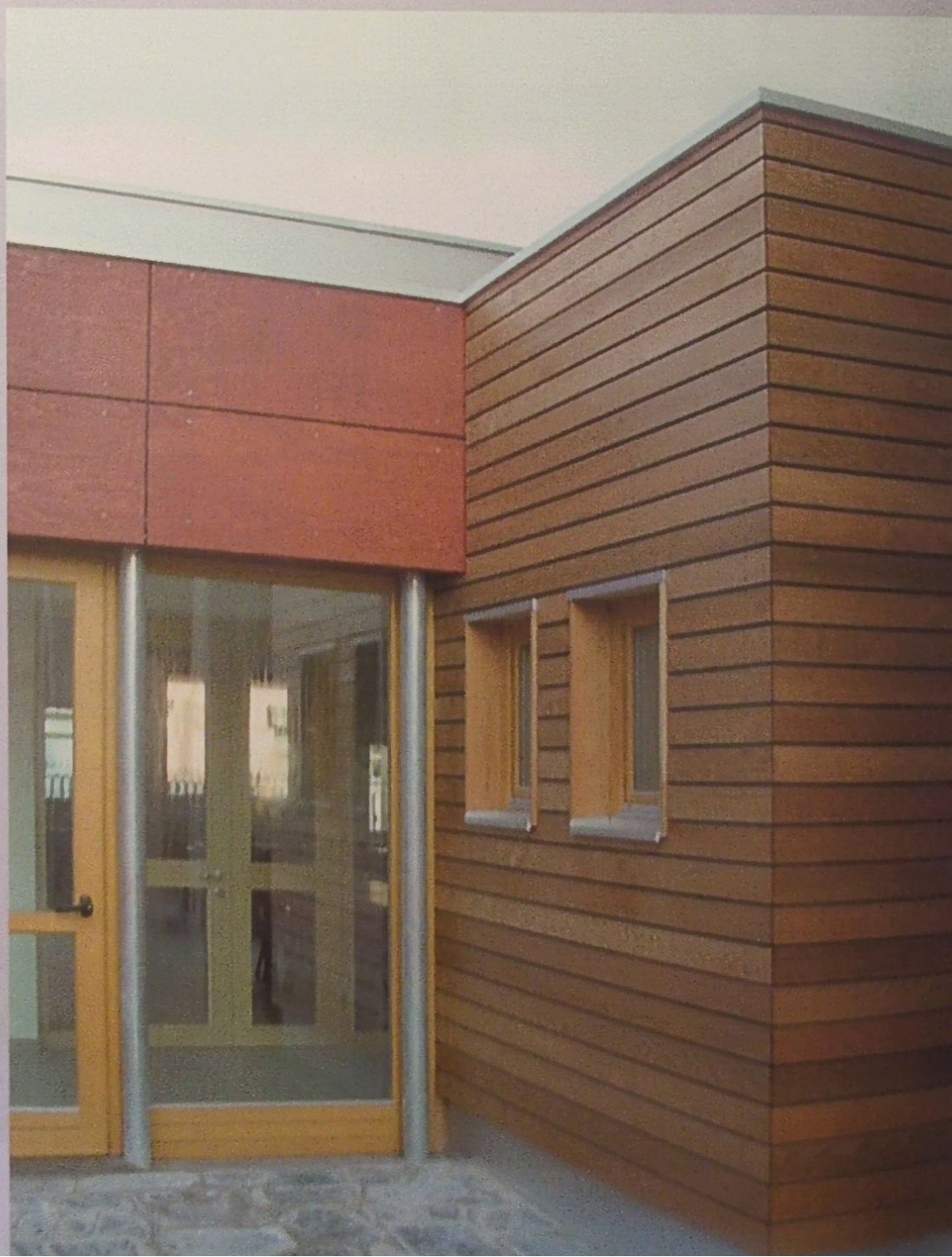
Fig. 2.25 – Dettaglio di finitura parietale esterna.
