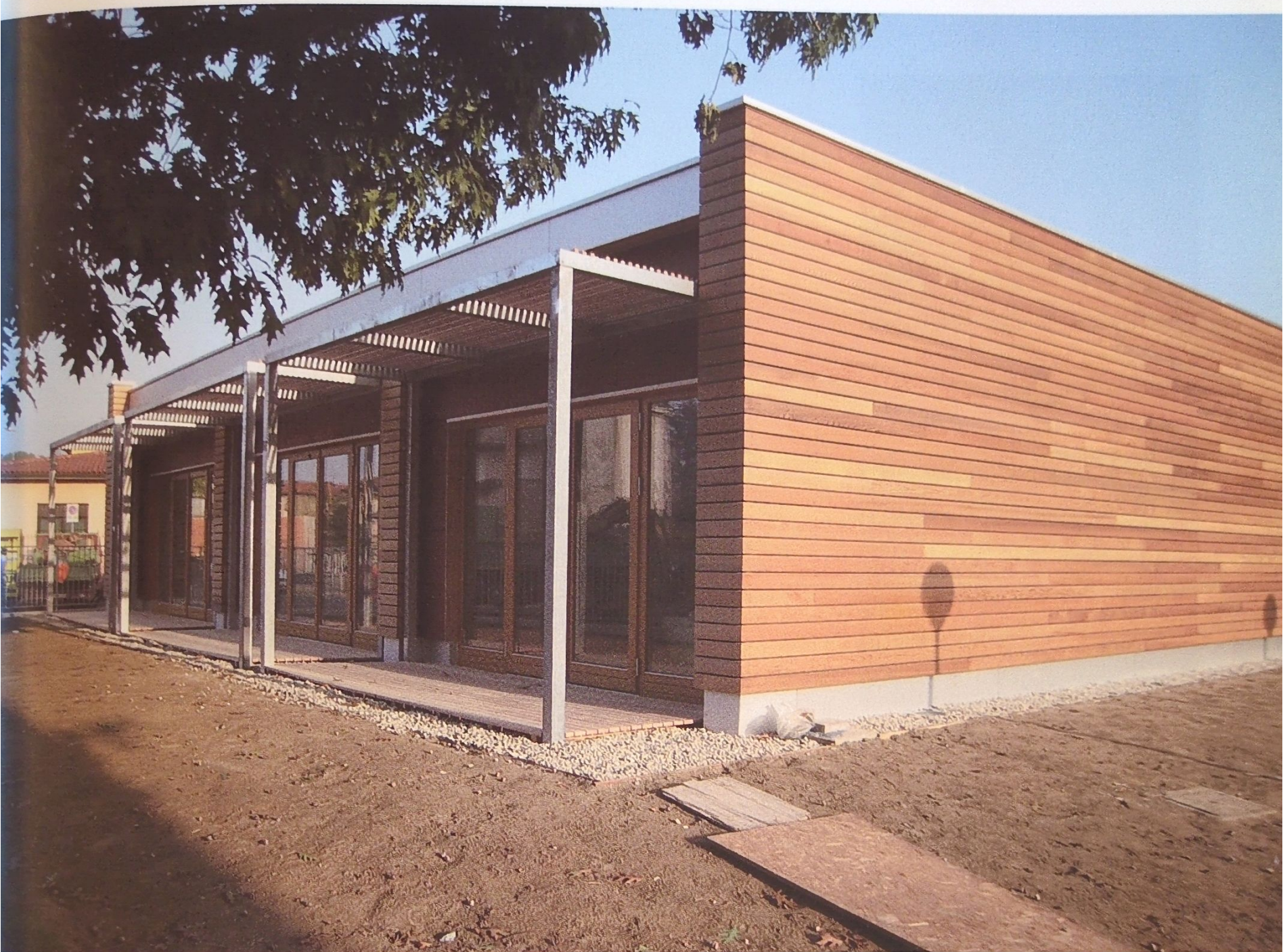
Fig. 2.26 – I corpi dei laboratori con ampio fronte finestrato esposto a sud.
