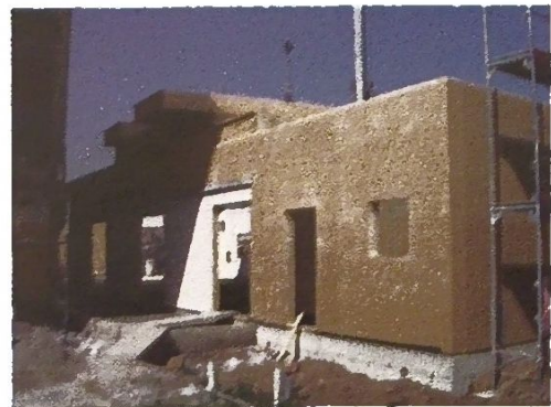
Fig. 2.33 - Foto di cantiere: posa pannelli a cappotto esterno in fibra di legno.
