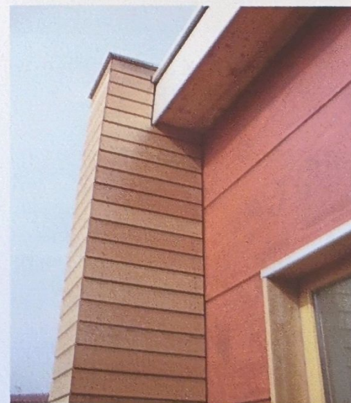
Fig. 2.28 – Dettaglio dell'incrocio sistema di copertura-facciata.
