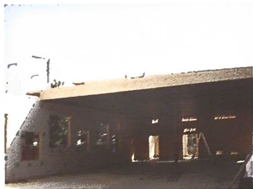
Fig. 2.32 - Foto di cantiere: posa copertura prefabbricata.
