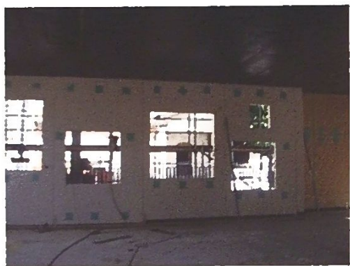
Fig. 2.31 - Foto di cantiere: posa dei pannelli in fibrogesso.
